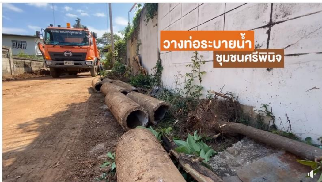
[EP.18] นครอุดร Movement: วางท่อระบายน้ำ ชุมชนศรีพิณิจ
